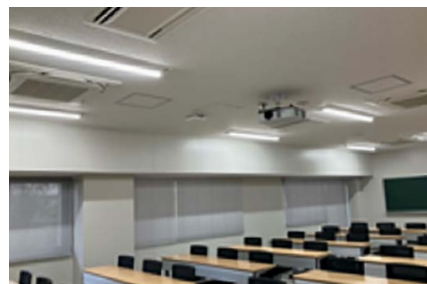
改修後（LED照明）
