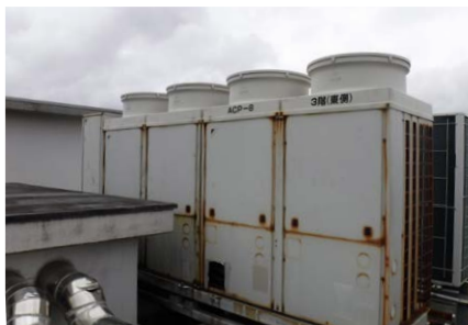
改修前（室外機）
